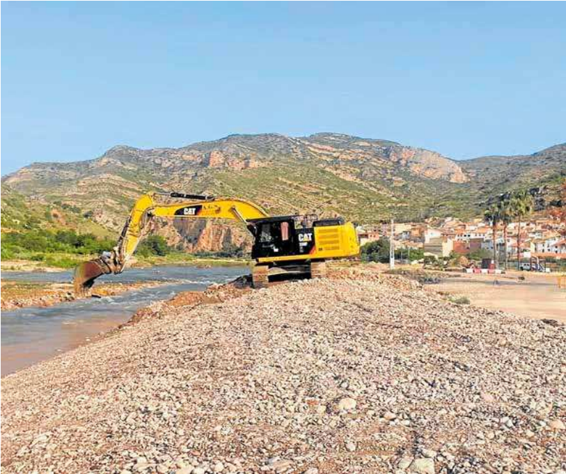
Acondicionamiento de una de las riberas del Turia dañadas el 29 de octubre. LP
